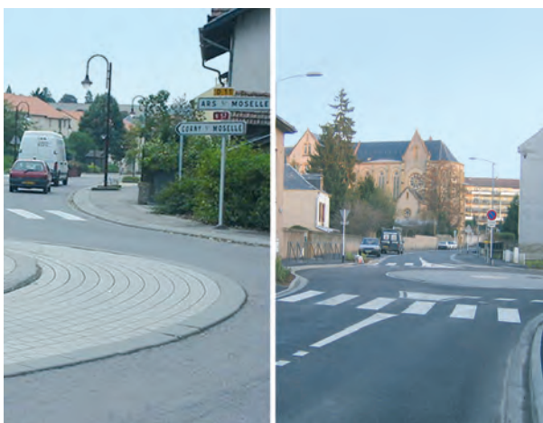
Îlot central ceinturé par des bordures ayant un profil non agressif et dont l'image est plus urbaine que celles de type A ou I.
