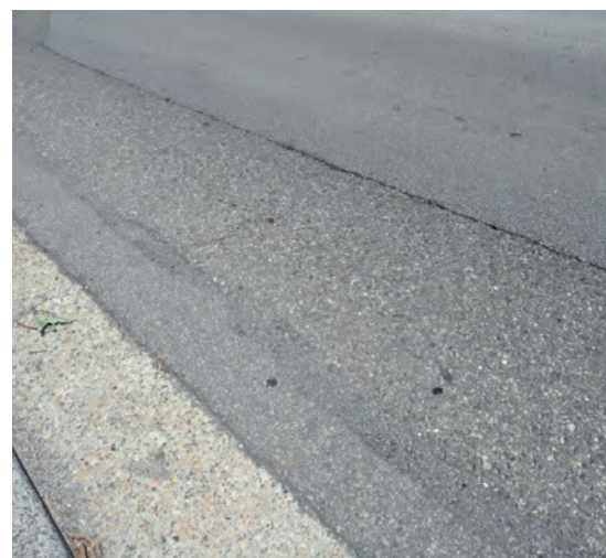
Exemple de réfection de tranchée définitive résistant au passage de bus sans se déformer.
