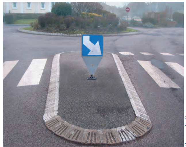
Système de signalisation J5 autorelevable sur îlot séparateur de giratoire en France.
