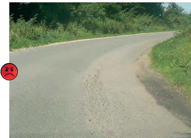
Les enduits superficiels sont essentiellement réalisés sur les routes secondaires en rase campagne. Ils s'accompagnent de gravillonnages présentant de sérieux risques de glissance pour les 2RM.
