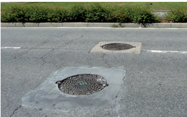
Exemple de plaque dont le scellement ne présente aucun danger pour un usager 2RM.
