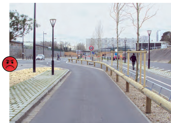
Cette barrière bois est plus utilisée pour guider les automobilistes que pour les protéger des chocs (limitation à 30 km/h en zone urbaine). Les supports peuvent constituer un danger pour les 2RM.
