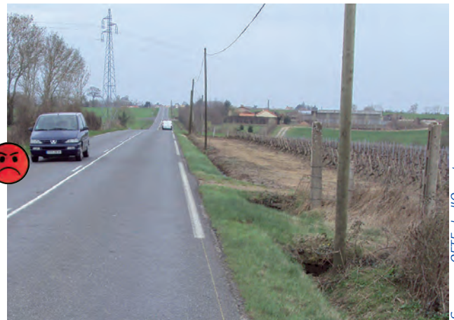
Fossés proches de la chaussée, têtes de buse non protégées, poteaux... Les accotements de nombreuses routes à trafic faible ou modéré présentent encore des risques pour les véhicules en perte de contrôle. À défaut de pouvoir investir dans un élargissement de l'emprise, le gestionnaire peut supprimer, déplacer, voire fragiliser certains obstacles.
