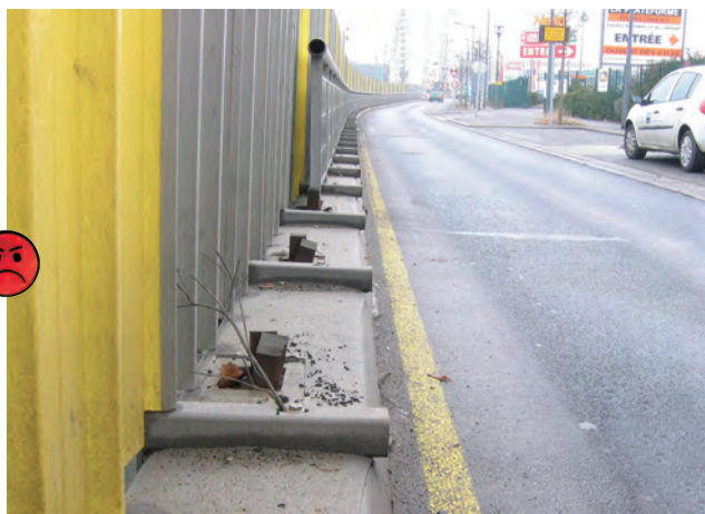
Un exemple de ce qu'il ne faut pas faire avec ces supports de palissade trop proches de la chaussée et ce garde-corps saillant.
