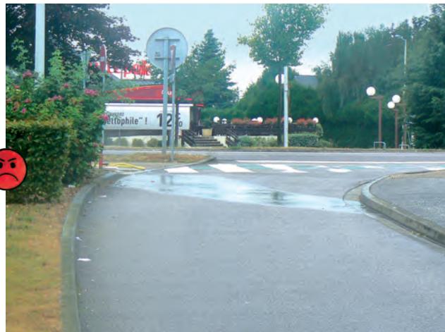
Arrosage avec écoulement d'eau sur la chaussée à l'abord d'un STOP en curve. Contrairement à une chaussée mouillée par la pluie, l'usager n'aura pas forcément anticipé une glissance ponctuelle du sol.
