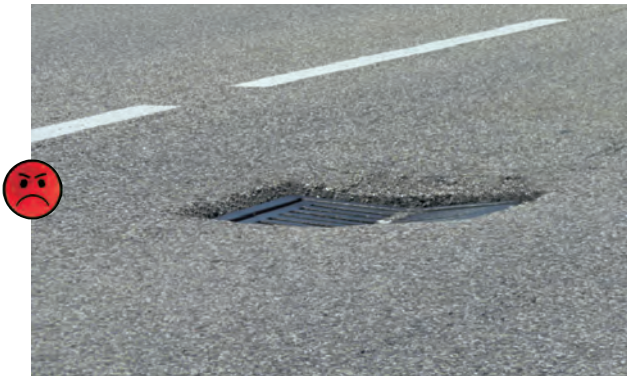
Exemple de bouche d'égout située au milieu de la chaussée et n'étant pas à niveau de celle-ci.
