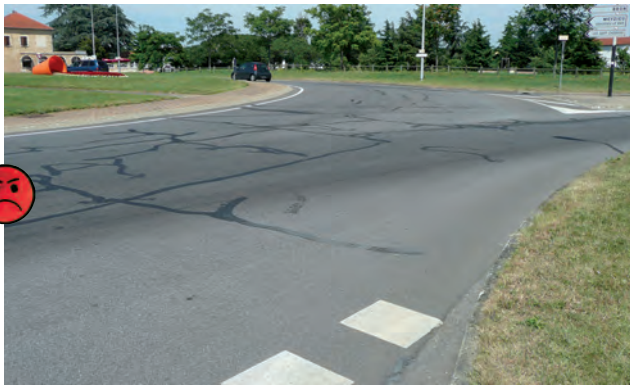
Exemple de joint de chaussée pouvant être dangereux pour un 2RM dans un giratoire.
