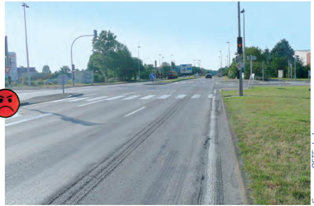
Exemple de rabotage permanent de la chaussée utilisé pour compenser l'ornièrage de la chaussée. Ce rabotage est dangereux pour un usager 2RM, car il se situe en zone de freinage.
