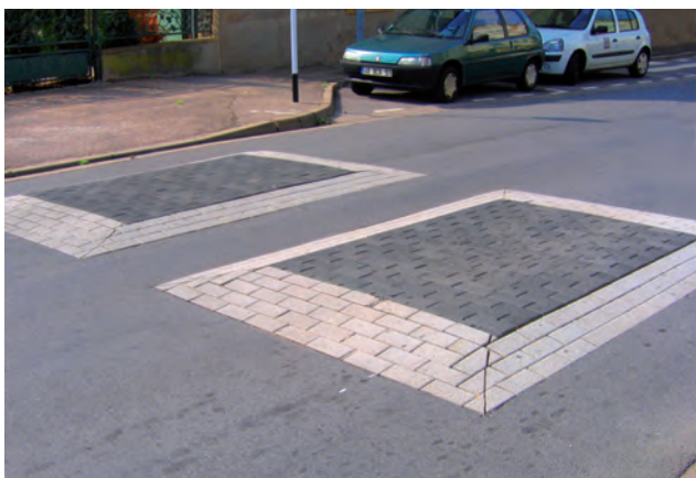
Coussin construit sur place
