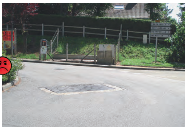
La trajectoire d'un 2RM effectuant un tourne-à-gauche passe sur la plaque non revêtue située sur l'anneau d'un giratoire.
