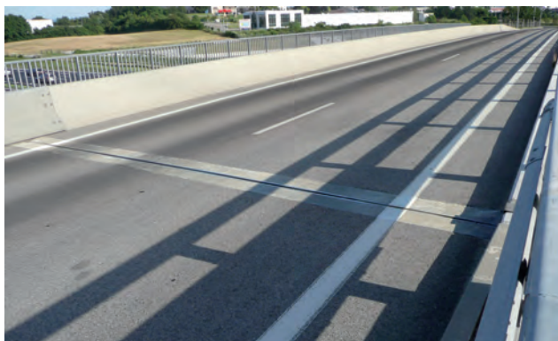
Exemple de joint d'ouvrage d'art ne présentant aucun danger pour un usager 2RM.
