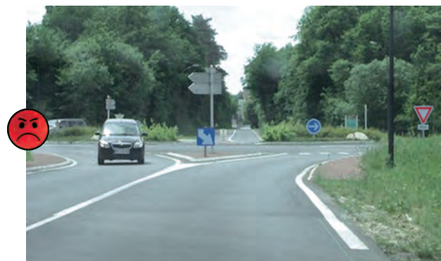
Carrefour giratoire présentant une mauvaise visibilité (perspective linéaire) : les vitesses risquent d'être inadaptées.
