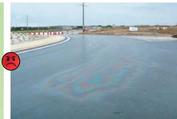
Déversement de gasoil dans un giratoire.
